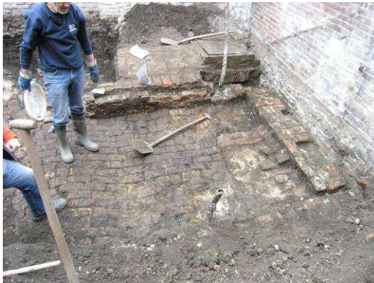
Afb. 19 In de hoek stookplaats 3D tegen muur 3B, vloer 3F sluit erop aan
