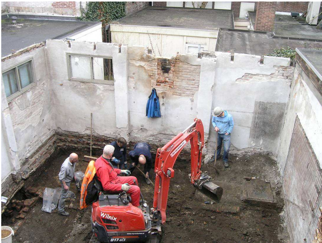
Afb.6 Overzicht van graafwerk in de achtertuin. De buitenmuur van het bijgebouw staat direct op de 14 de -eeuwse funderingen 2A en 2B
