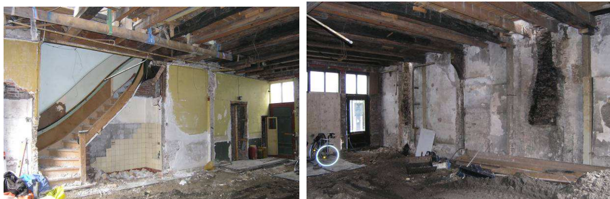
Afb.22a-b Boterstraat 6/8 tijdens de verbouwing, links de noord- en rechts de zuidmuur
