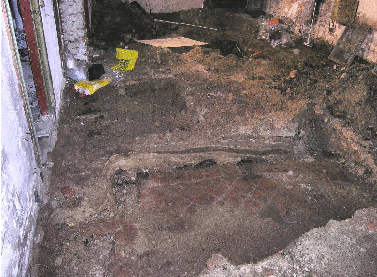
Afb. 11 Plavuizenvloer 2F, vanuit het westen gezien
