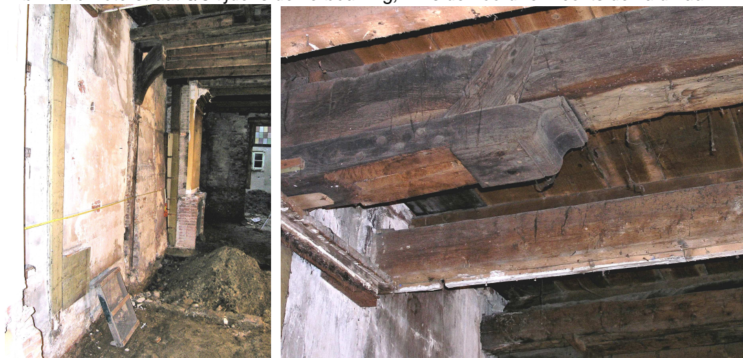
Afb.23a-b Eikenhouten gebint aan de zuidzijde, rechts aanzet van de kapjuk aan de voorste balklaag
