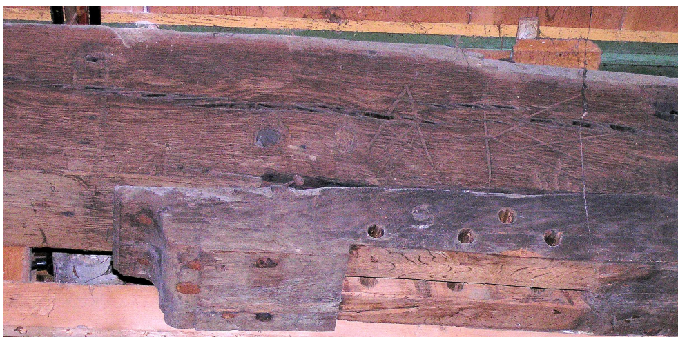
Afb.24a-c Het eikenhouten gebint aan de noordzijde, rechtsboven de aanzet van de kapjuk aan de voorste balklaag, onder een vlottersmerkteken op de balk
